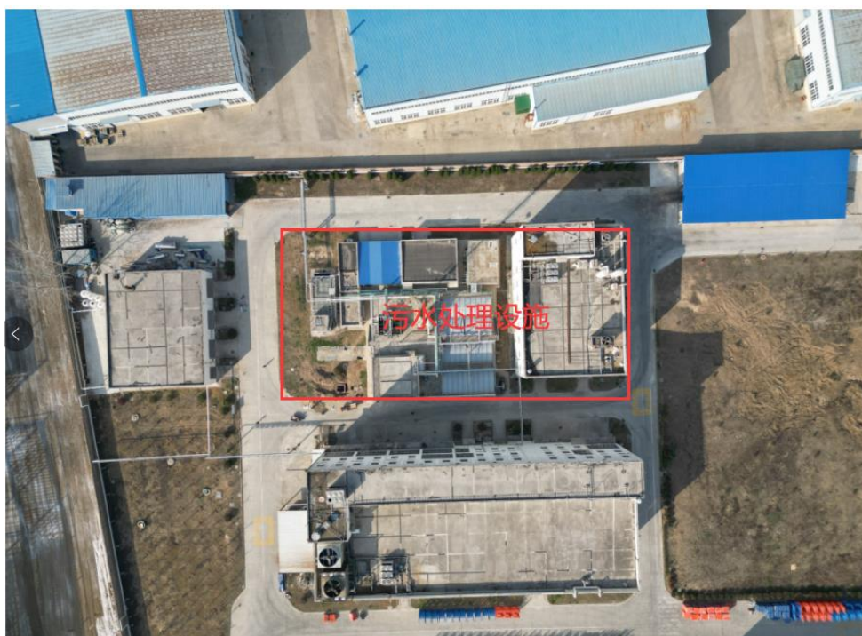
污水处理设施
