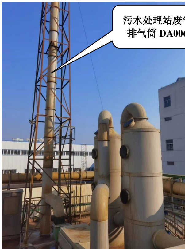
污水处理站废气排气筒
