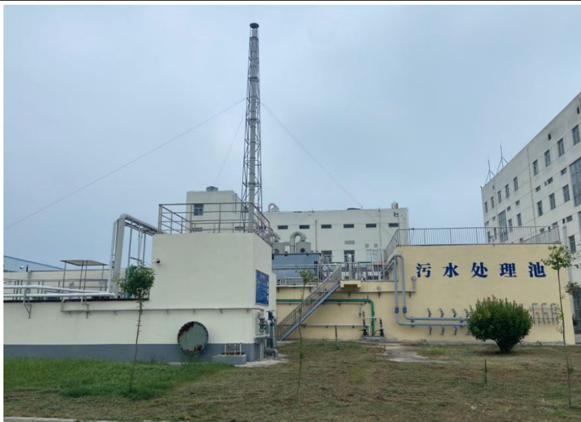
污水处理设施
